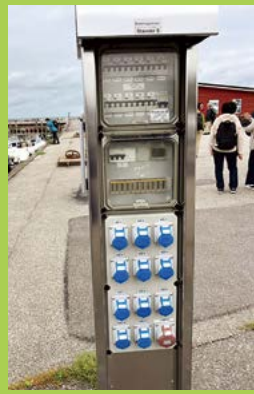
島の港に設置してあるボート用の充電器 港の中では再エネの電力しか使えません
