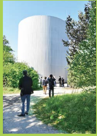
温水を貯蔵するタンク
