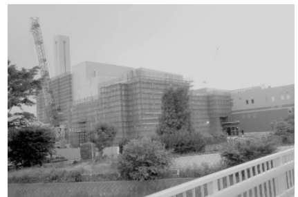
建設中の新クリーンセンター
